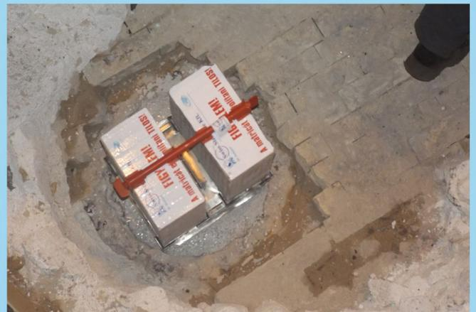
В зависимости от площади днища металлургической емкости площадь продувочного устройства должна быть соответственно больше. Нами установлено, что площадь продувочного устройства должна быть равной 0,1- 0,5 части площади днища. Для обеспечения такой площади продувочное устройство набирается из секций, такое наборное продувочное устройство получило название «блок ШПР».
